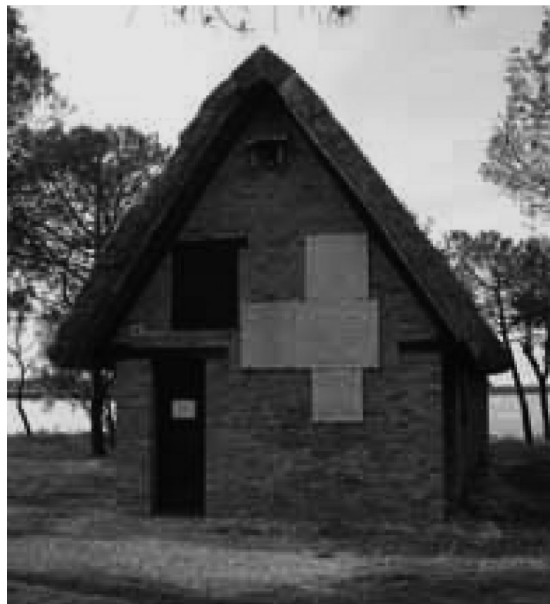
Il Capanno ha il tetto nuovo
