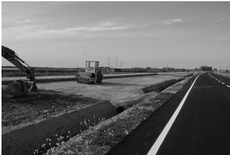
Buldozer che spiana il nuovo parcheggio lungo la "Baiona"
