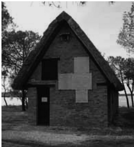
Il Capanno ha il tetto nuovo
